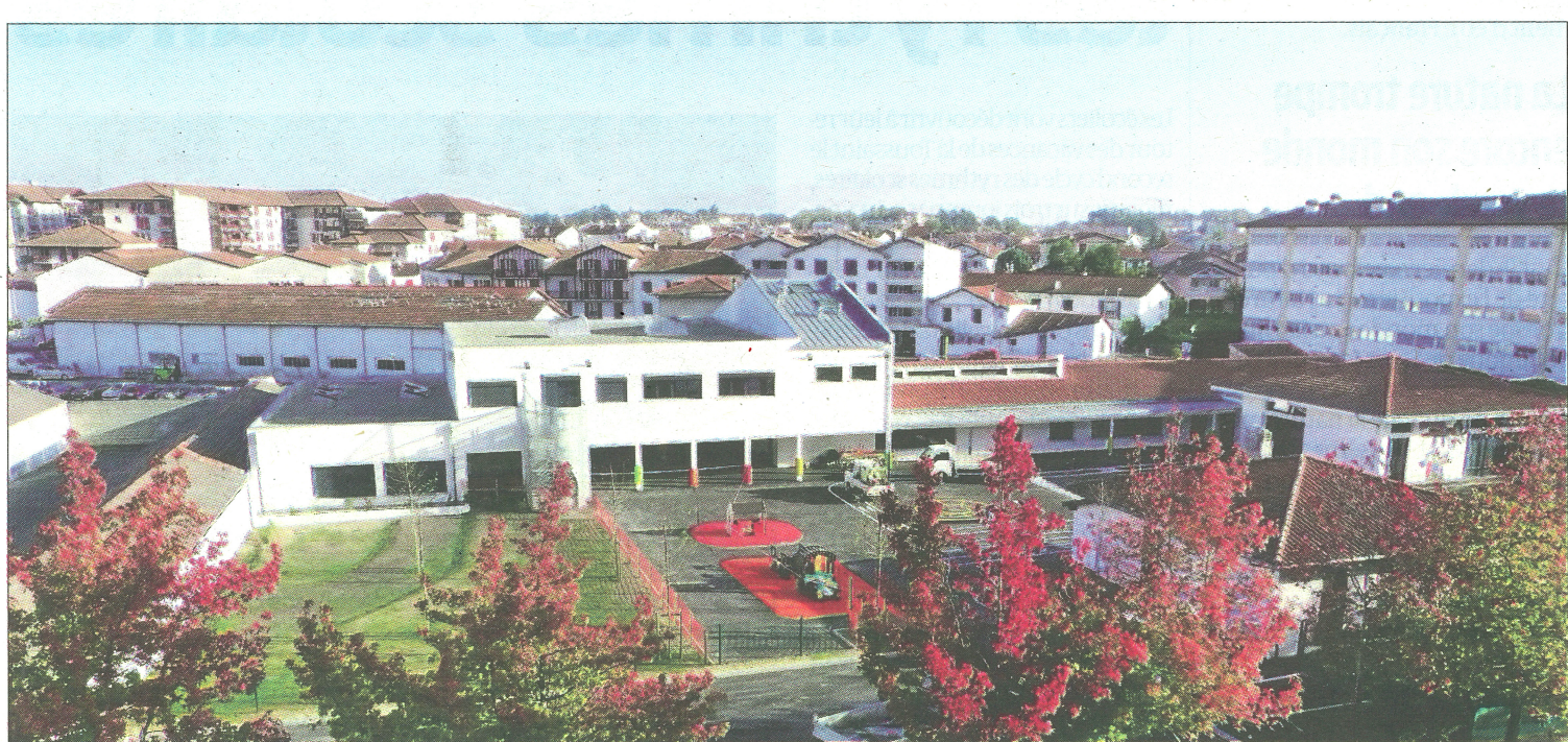
À droite, la partie ancienne a été conservée et remodelée. À gauche, une extension moderne d'un étage a été construite. PHOTOS R. G.
